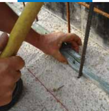
Sormonto dei capi di Idrostop B25
