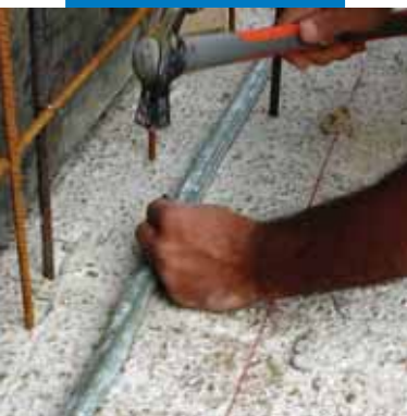
Fissaggio di Idrostop B25 alla ripresa di getto
