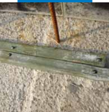
Sormonto dei capi di Idrostop B25
