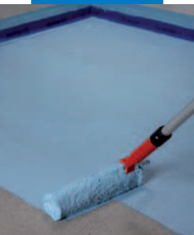
Applicazione della prima mano di Mapelastic AquaDefense su massetto
