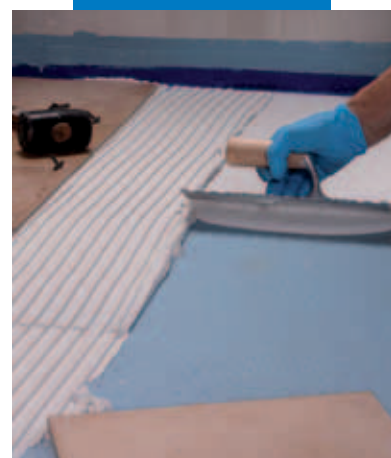
Incollaggio delle piastrelle su Mapelastic AquaDefense
