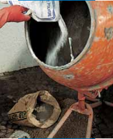
Preparazione della malta idrofuga additivata con Idrosilex Polvere
