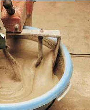
Impasto di Idrosilex Pronto grigio con acqua
