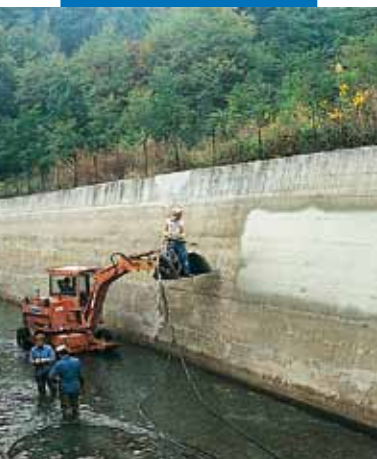
Applicazione a spruzzo di Idrosilex Pronto in canale idroelettrico
