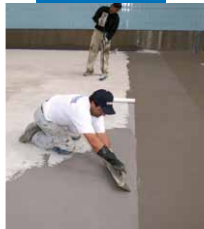
Impermeabilizzazione di una piscina con Mapelastic
