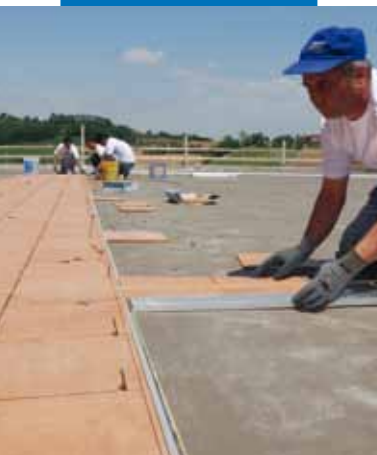
Posa di ceramica con Kerabond + Isolastic
