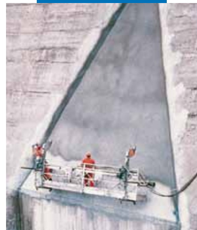
Esempio di applicazione a spruzzo di Mapelastic in una diga
