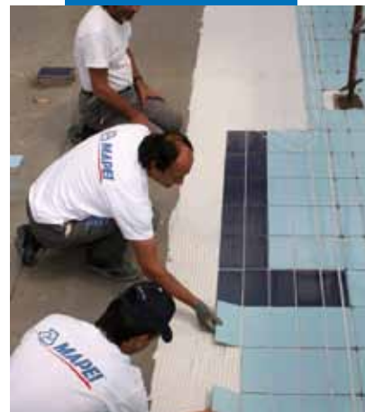
Posa di rivestimento ceramico su Mapelastic
