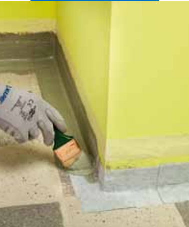
Applicazione di Mapeband SA su massetto
