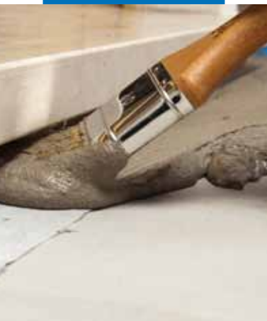
Applicazione di Mapeband SA su punti di difficile accesso quali sottosoglia
