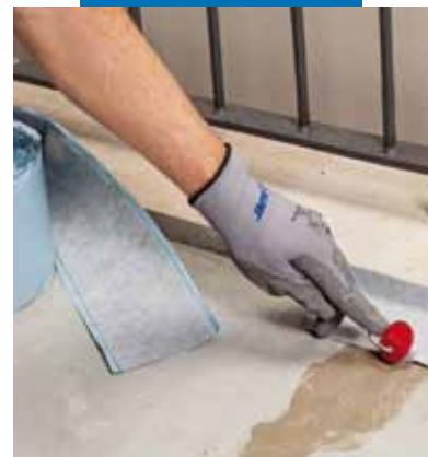
Applicazione di Mapeband SA negli spigoli
