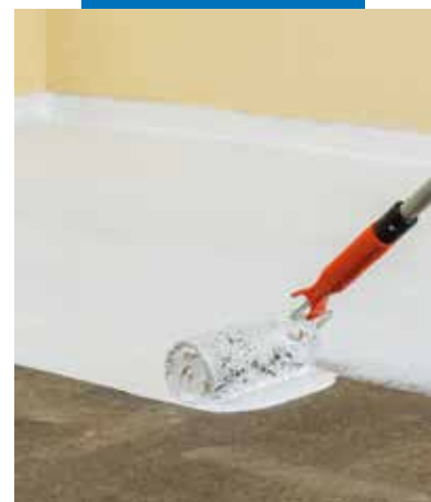
Applicazione della prima mano di Aquaflex Roof Premium
