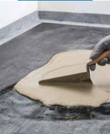
Ripristino degli avvallamenti con MapeSlope previa applicazione di Primer P3
