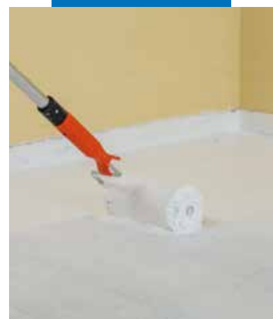
Applicazione della seconda mano di Aquaflex Roof Premium
