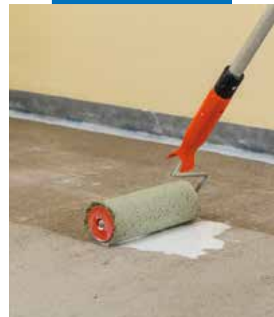
Supporto cementizio primerizzato con Mapecoat I 600 W
