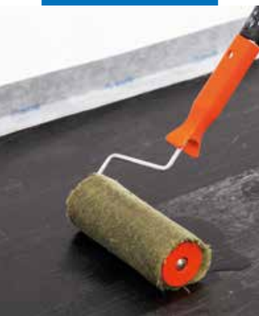
Applicazione di Primer per Aquaflex su guaina bituminosa liscia esistente
