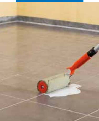
Applicazione di Mapecoat I 600 W su piastrelle opportunamente preparate
