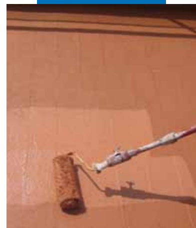
Applicazione di Aquaflex Roof con rullo a pelo lungo
